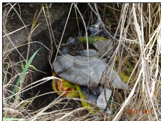
Figura 39. Resíduos lançados na drenagem.
