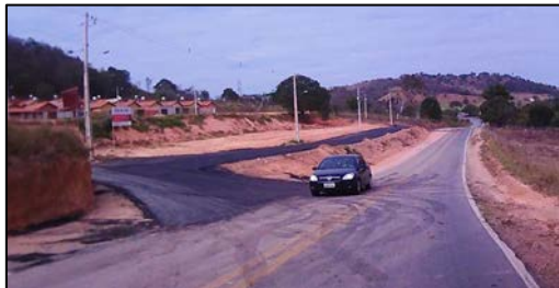
Figura 41. Acessos irregulares são comuns no trecho da LMG-801
