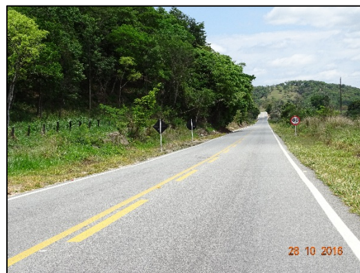
Figura 5. Aspecto geral do eixo da rodovia e faixa de domínio (ADA).
