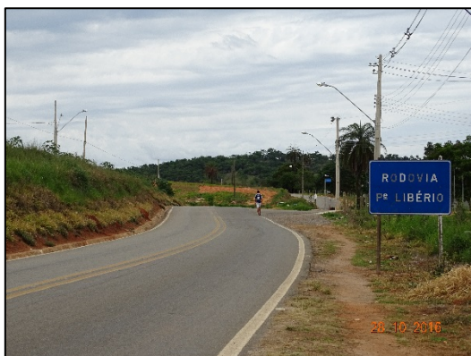
Figura 2. Início do trecho pavimentado.
