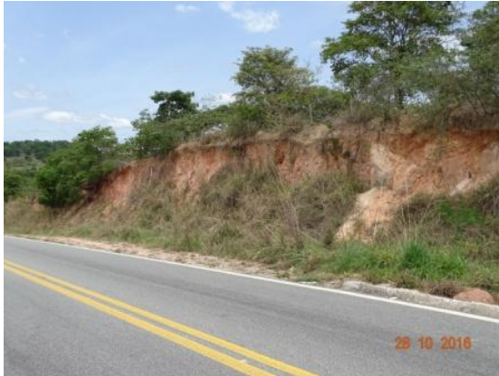
Figura 36 –Aspecto geral do talude
