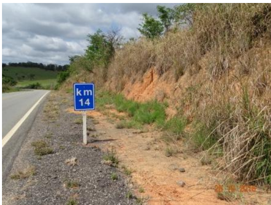
Figura 44-Aspecto geral do talude
