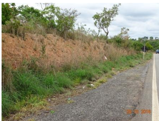
Figura 47 - Visão geral talude - T10
