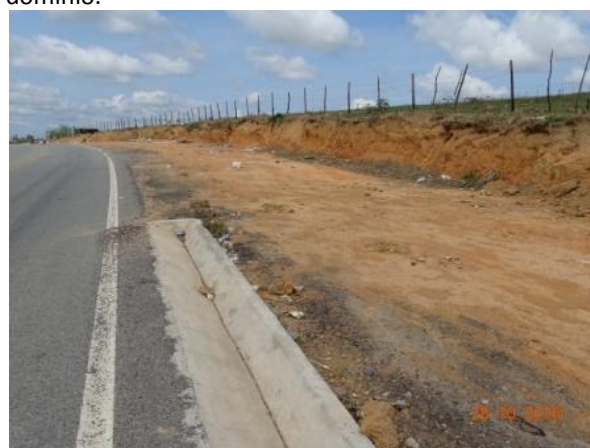
Figura 28 – Aspecto geral EL
