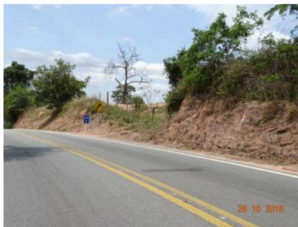
Figura 35 - Visão geral de talude corte
