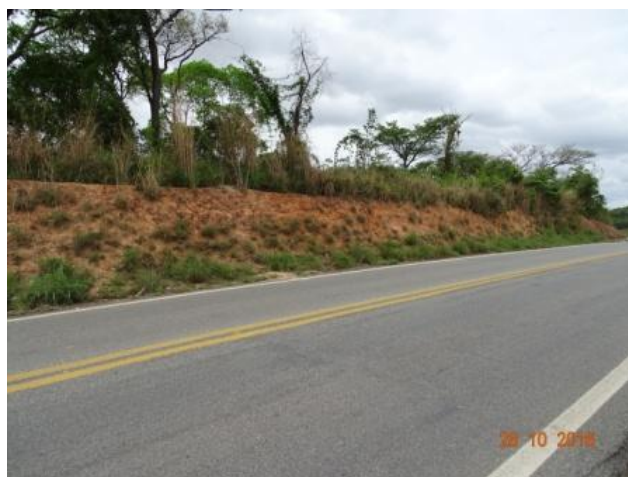
Figura 46 - Visão geral talude - T09
