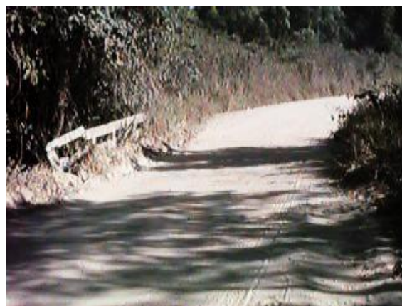
Figura 6 - Ponte sobre o Córrego Ponte alta, antes da pavimentação
