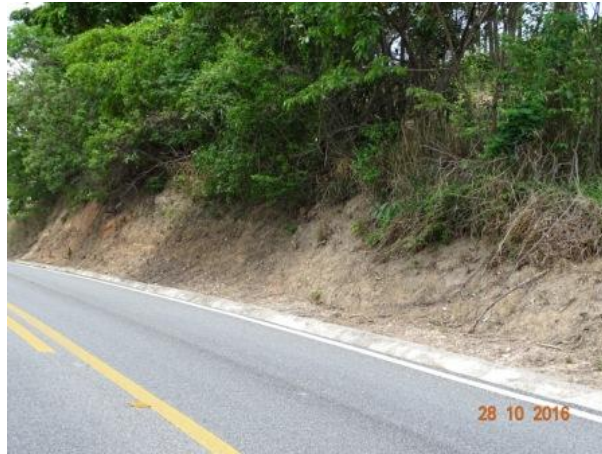
Figura 41 - Visão geral talude - T05
