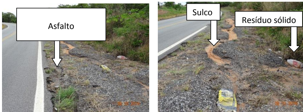
Figura 29 - Aspecto geral do empréstimo lateral - EL - 03
