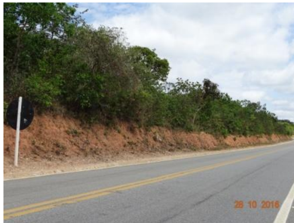
Figura 43 - Visão geral talude- T07
