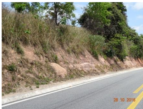
Figura 39 - Visão geral talude T-03
