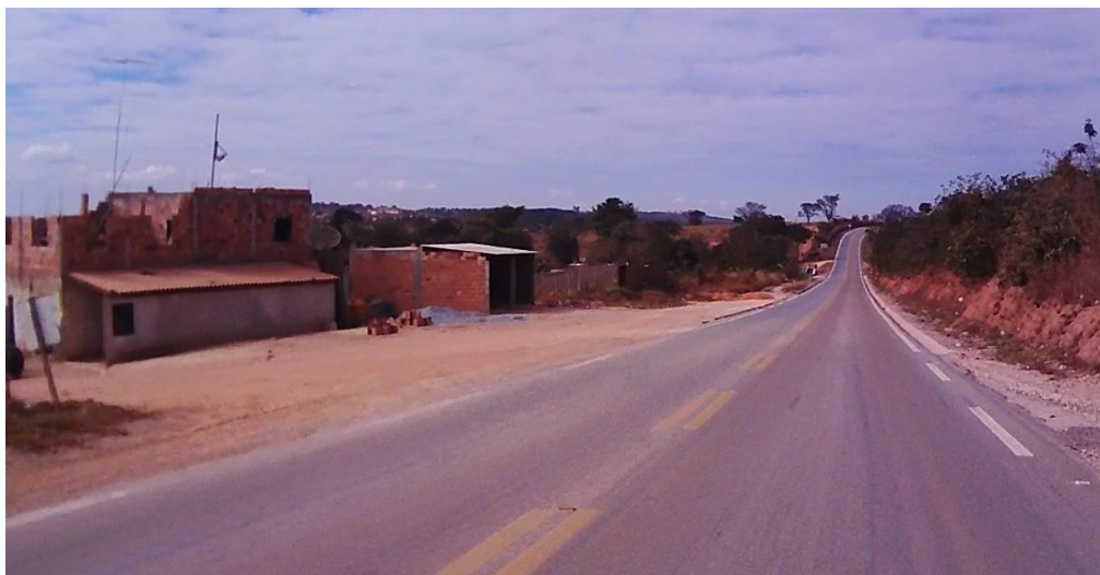
Figura 20 - Acessos irregulares que provocam aumento do atrito lateral à via e danificação da camada de rolamento e sinalização horizontal
