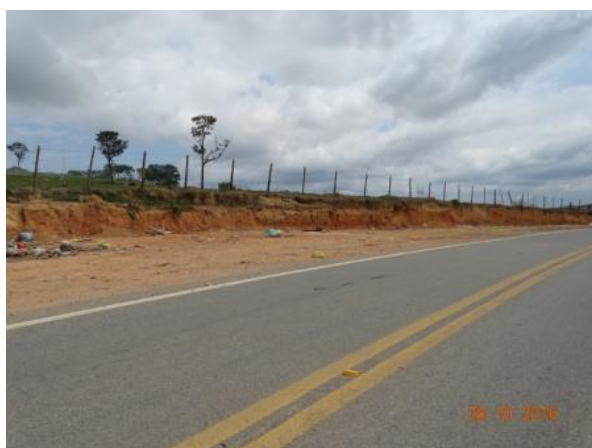
Figura 27 – Aspecto geral EL
