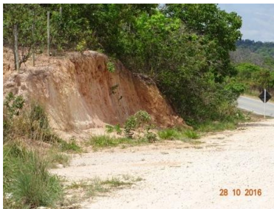
Figura 42 - Visão geral talude - T06
