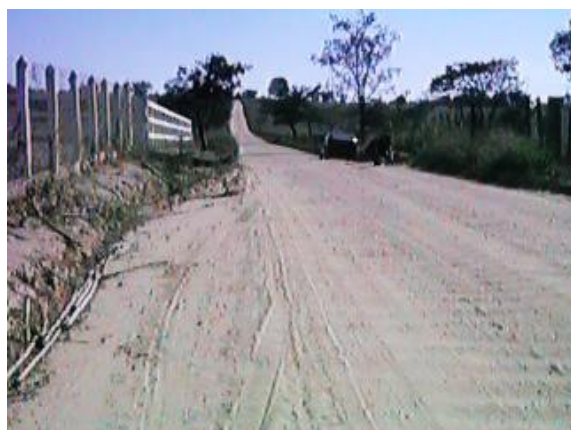
Figura 5 - Aspecto geral da estrada antes da pavimentação
