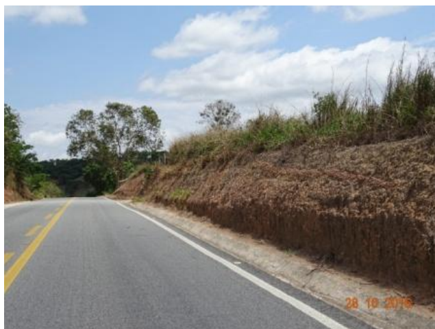
Figura 40 - Visão geral talude - T04
